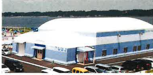
テント型屋内競技施設スポーツプラザ (いこいの村沼沼敷地内)
